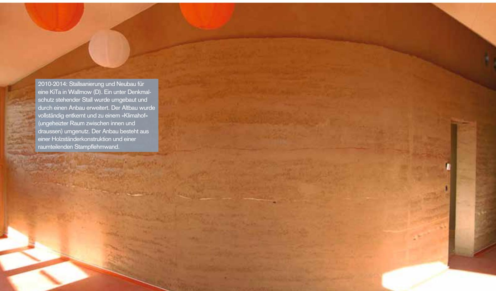
2010-2014: Stallsanierung und Neubau für eine KiTa in Wallmow (D). Ein unter Denkmalschutz stehender Stall wurde umgebaut und durch einen Anbau erweitert. Der Altbau wurde vollständig entkernt und zu einem «Klimahof» (ungeheizter Raum zwischen innen und draussen) umgenutzt. Der Anbau besteht aus einer Holzständerkonstruktion und einer raumteilenden Stampflehmwand.
